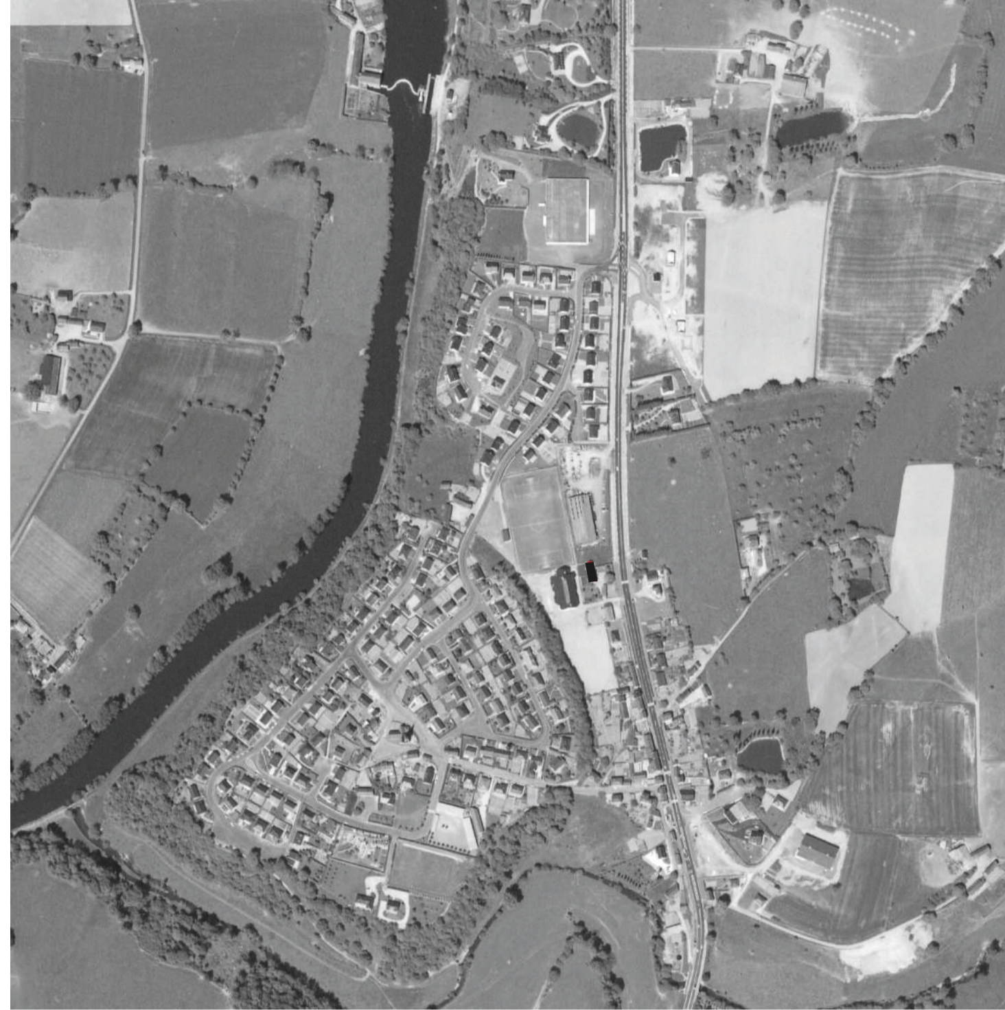
MAIRIE ET ÉCOLE AU CENTRE GÉOGRAPHIQUE PHOTO AÉRIENNE 1987
